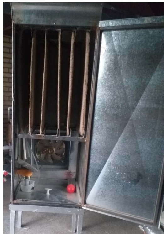
شکل ۳: نحوه قرارگیری درب پشتی، پمپ آب و سطح های مرطوب شونده در خنک کننده تبخیری
